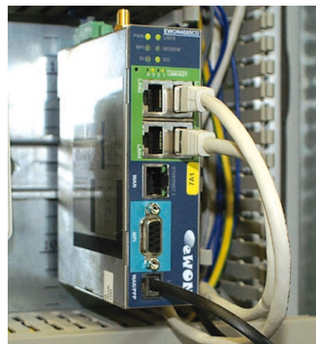
Das kompakte Fernwirkmodul findet in jeder Verteilung Platz und kann unterschiedliche Medien zur Anbindung von Anlagen an das Internet nutzen
